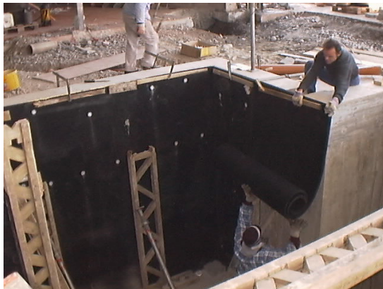
Verkleben der 2-fach Isoliermatten
